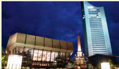
Gewandhaus und City Hochhaus
