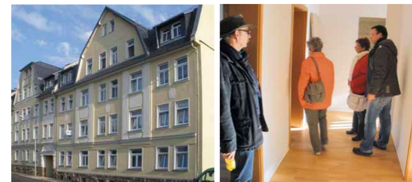
In der Georgstraße warten sanierte Wohnungen auf neue Mieter.
